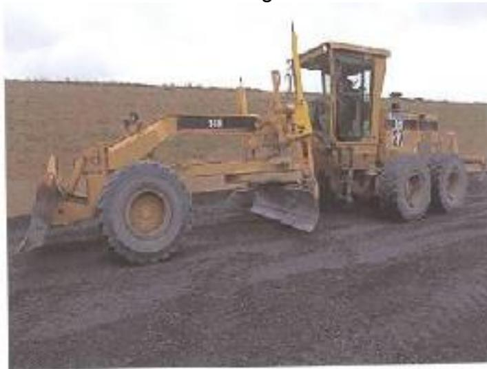
Pendant son répandage, le tout-venant sera arrose de telle sorte que sa teneur en eau soit portée à une valeur supérieure de deux points à celle correspondant à l'optimum de l'essai POROCTOR modifié (O.P.M) la lame de niveleuse sera constamment chargée au maximum et orientée autant que possible perpendiculairement au sens de la marche.
