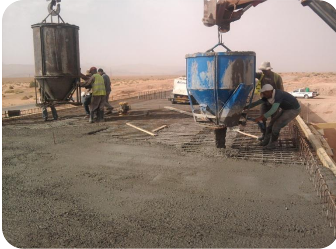
Mise en œuvre du béton sur le tablier : le 13 juillet 2011
